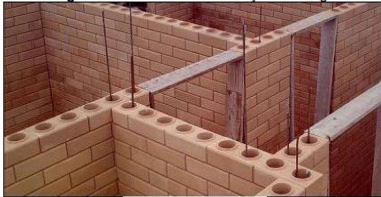
Figura 2 – Assentamento dos tijolos ecológicos.
