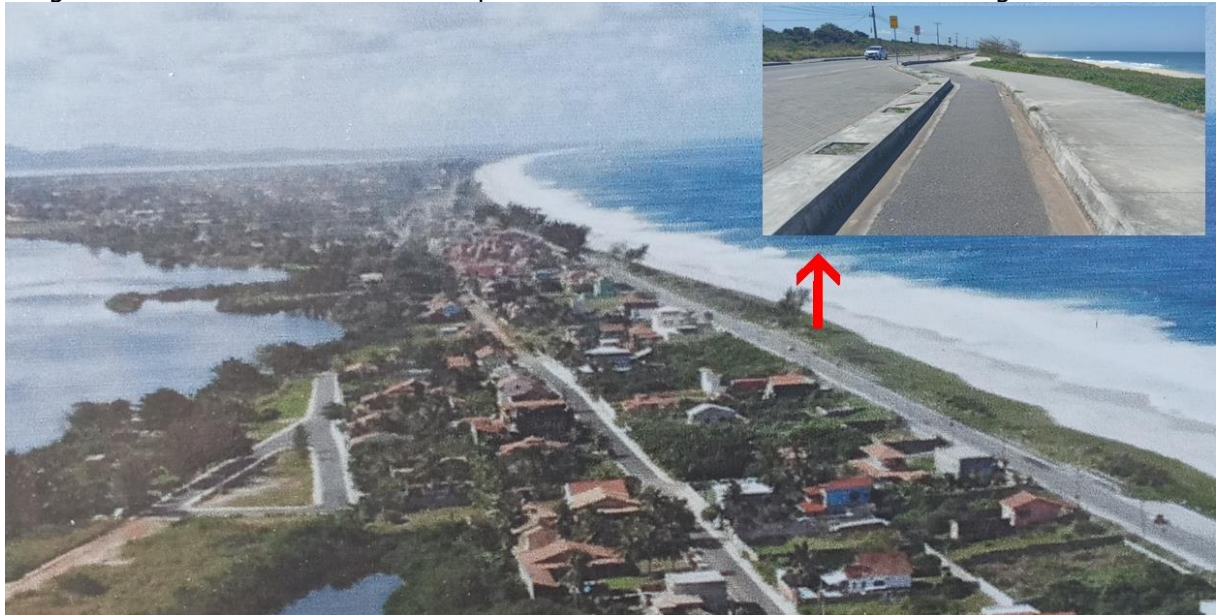
Figura 3 - Vista Aérea da Orla da praia de Jaconé - Maricá e acesso à Lagoa de Jaconé.
